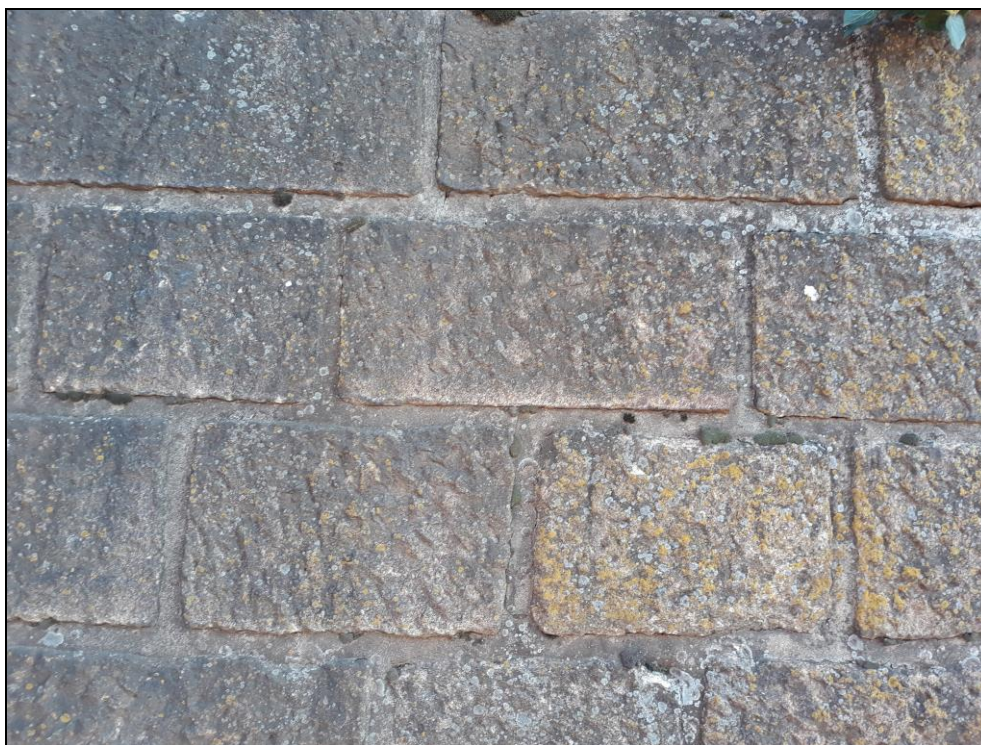
Obr. č. 5 - detail lícového řádkového zdiva opěrné zdi
